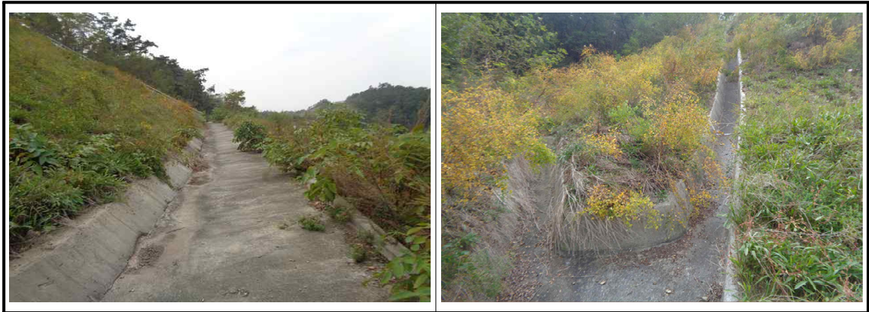
【그림 7.3.3】 배수시설 전경
