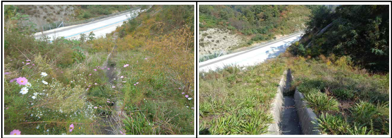
【그림 7.3.1】 상부자연사면 전경
